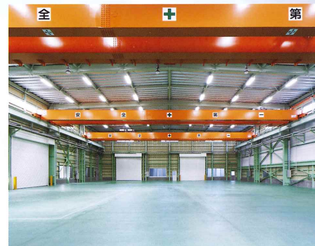
新工場内観（クレーン完備）
