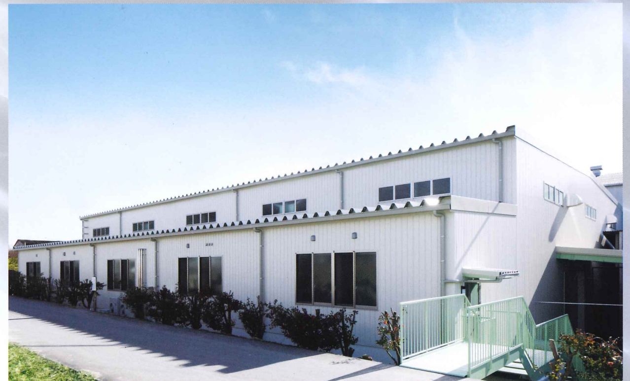
プレハブ配管新工場外観
